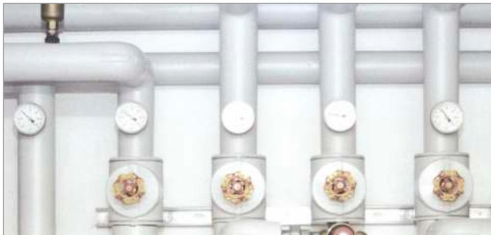
Um die verschiedenen Rohrdurchmesser passgenau zu ummanteln kann die Folie anhand eines PVC Schneidetesches [s.1.4] Millimetergenau zugeschnitten werden.
