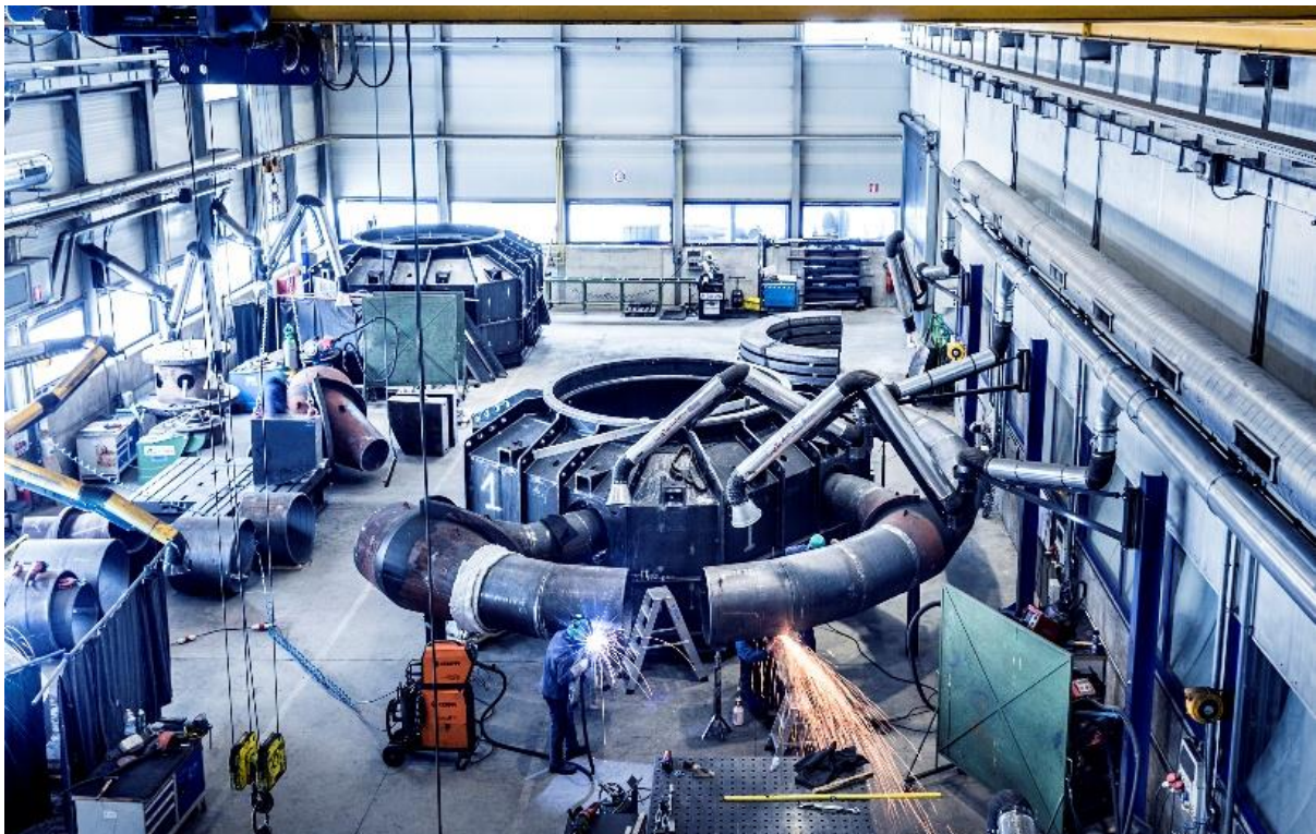
Anlage "St. Anton", Bozen, Südtirol, Baujahr 2018
