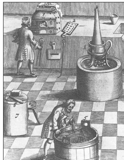
Figura 7 - Misura della densità (in primo piano) a Londra, 17° secolo. In fondo si vede la prova al fuoco (dalla citazione 1)
